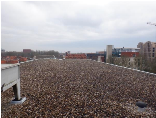
Foto dak met niet verdachte dakbedekking
