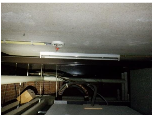
Foto ruimte tussen verlaagd plafond en zolder
