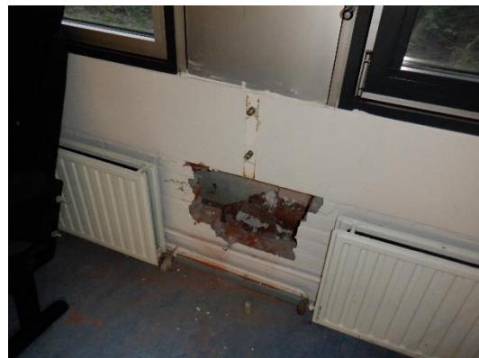
Foto opengewerkte gevel
