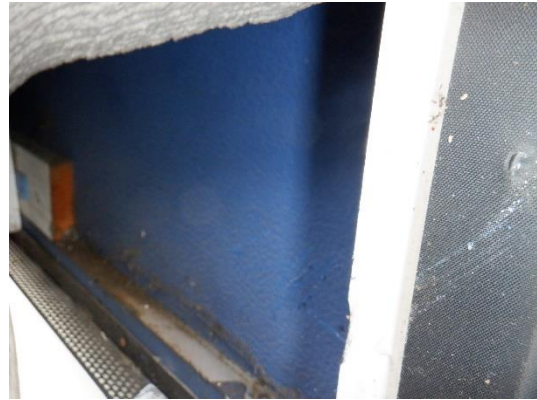
Foto houten beplating achter de trespa afwerking
