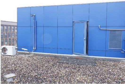
Foto afwerking 4e verdieping trespa
