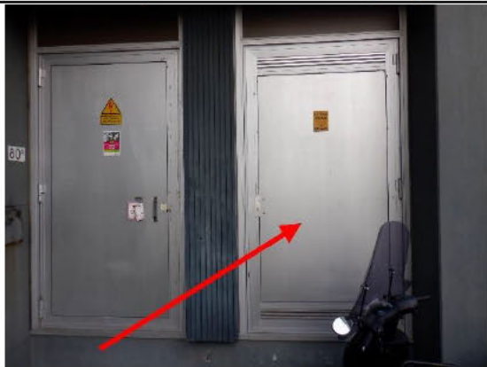
Foto 40 | Foto voor bron Plafond beplating
