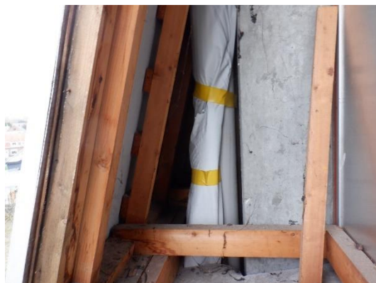
Foto pvc-hemelwaterafvoer achter betimmering buitenzijde
