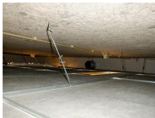
Foto ruimte tussen verlaagd plafond en zolder
