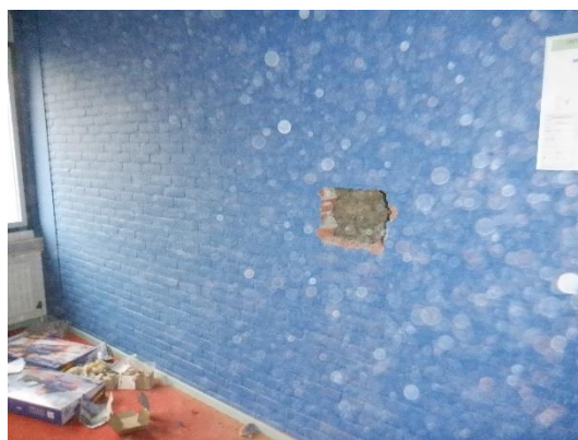
Foto opengewerkt bouwkundig kanaal
