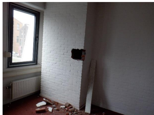
Foto opengebroken bouwkundig kanaal
