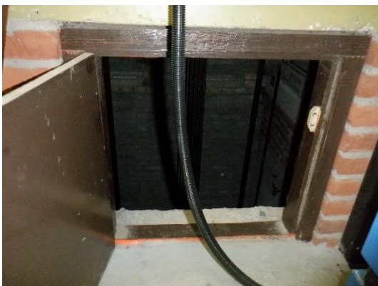
Foto toegang liftschacht
