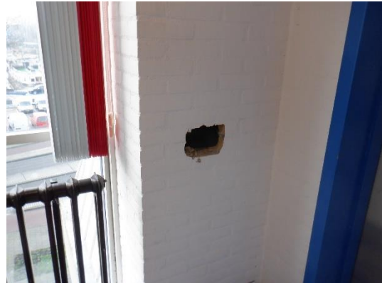
Foto opengewerkt leidingkanaal
