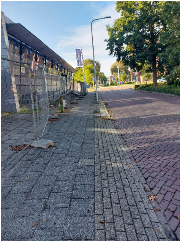
Trottoir voor bouw inrit
